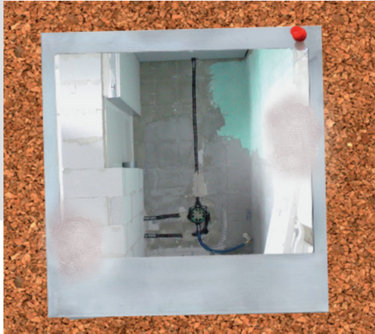
Die neue Duschseitenwand wurde mit Porenbetonsteinen gemauert. In der große Nische stehen später Shampoo und Co.
