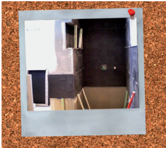
Die großformatigen Fliesen wurden auf den alten Belag geklebt. Nur in der Dusche kamen die alten Fliesen runter, um den Bereich abzudichten.
