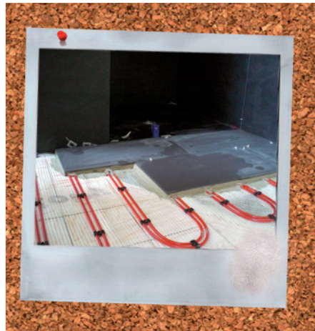
Inzwischen gibt es warmwassergeführte Fußbodenheizungssysteme zum Nachrüsten. Die Leitungen werden einfach im Fliesenkleber eingebettet.
