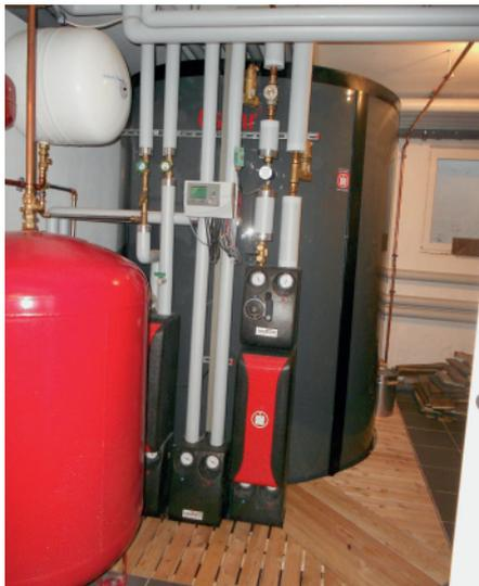
Im sehr gut gedämmten Wassertank wird die Sommerwärme für den Winter „eingelagert“.
