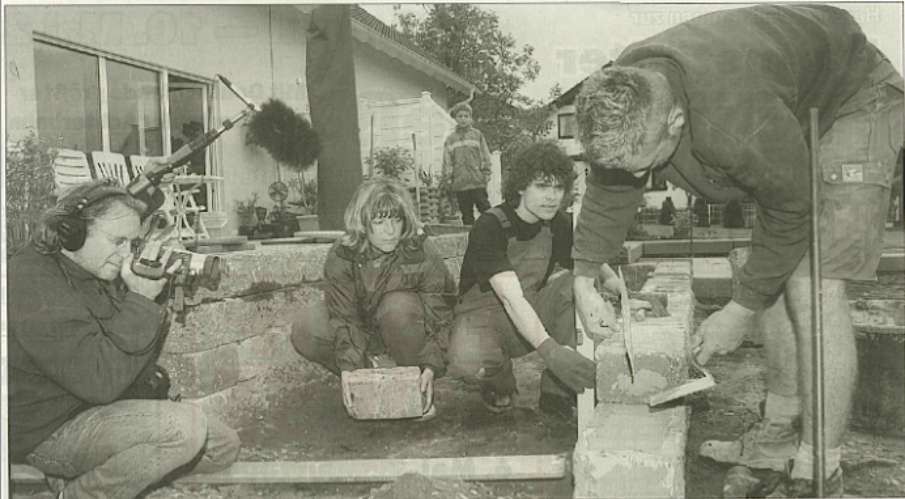
Mauern für den Traumgarten: Kameramann Uli Pförtner filmt, wie Patrizio Vetrano ein Mauerchen auf dem Grundstück der Familie Mohrmann in Hähnlein errichtet. Moderator Ronald Meyer legt die Wasserwaage an, Katrin Mohrmann hält den nächsten Stein bereit, Sohn Paul beobachtet die Arbeiten aus der Ferne. Der Beitrag über den japanischen Garten der Mohrmanns soll am 25. Mai in der Reihe „SOS Haus und Garten“ im Hessenfernsehen laufen.
