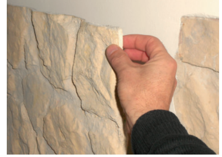
Dünne Platten mit großartiger Wirkung: Die nur wenige Millimeter dünnen Paneele aus glasfaserverstärktem Kunststoff werden einfach an die Wand geschraubt.
