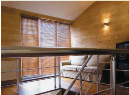
Dünne Platten mit großartiger Wirkung: Die nur wenige Millimeter dünnen Paneele aus glasfaserverstärktem Kunststoff werden einfach an die Wand geschraubt.
