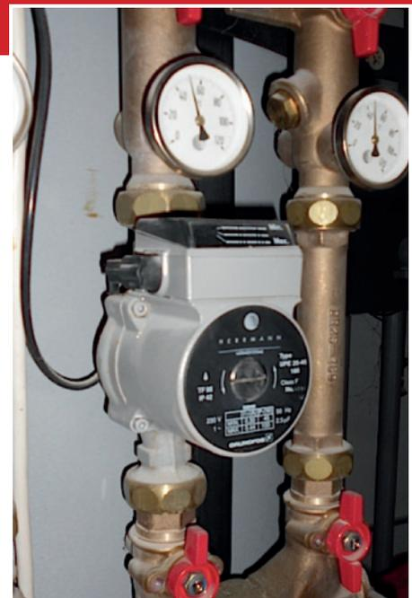
Heizungsumwälzpumpen fressen Strom. Ein Tausch gegen energiesparende Effizienzpumpen lohnt sich.
