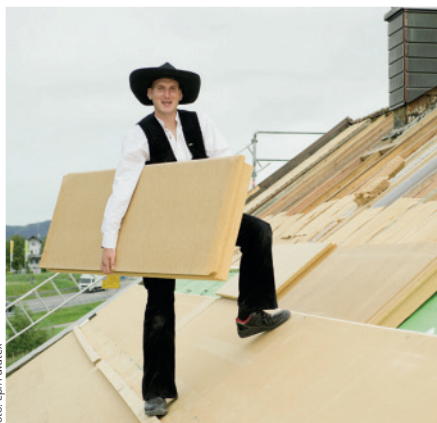
Trotz aller technischen Entwicklungen wird ein Haus nach wie vor „von Hand gebaut“.
