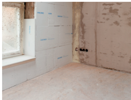
Die Innendämmung gibt es auch als System, inklusive Dämmplatten für die Fensterlaibung.
