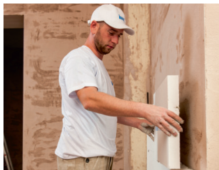
Auf einer Ausgleichsspachtelung werden die Innendämmplatten mit speziellem Klebemörtel verlegt.
