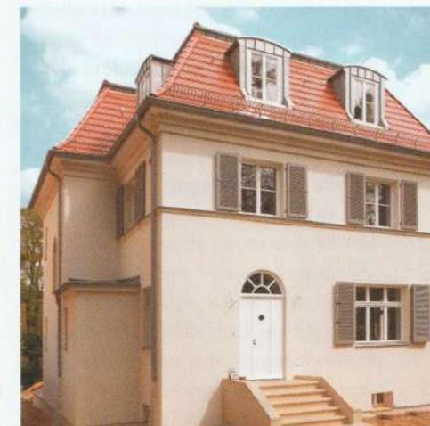
Bei Drei- oder Vierfachfenstern muss die alte Fassade gedämmt werden, bis ihr U-Wert besser ist als der U-Wert der neuen Fenster.
