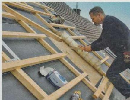
**25** Einbau Dachflächenfenster: Fensteröffnung auf der Unterdeckbahn exakt markieren und danach die Dämmung herauschneiden.
