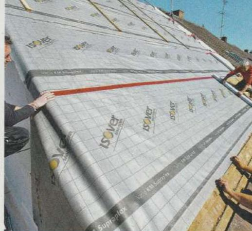
**11** Eine weitere Lage der Klima-Membran wird verlegt. Dabei die Stöße genau zehn Zentimeter überlappen lassen (Markierungen helfen, die Folie akkurat auszurichten).
