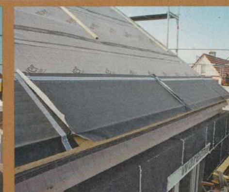
**18** Alle weiteren Platten nun so in eine Reihe legen, dass die aufkaschierte Unterspannbahn mit umlaufenden Klebe-streifen auf die jeweils benachbarte Platte überlappt.
