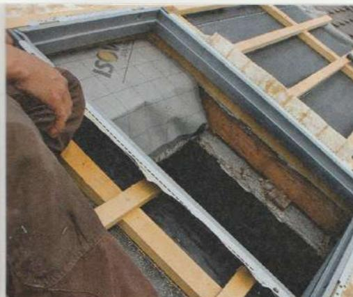
**26** Bevor der Blendrahmen eingebaut wird, den Fensterflügel aushängen. Dann die Einbautiefe festlegen, damit das Fenster später in der richtigen Höhe sitzt.
