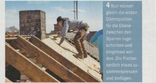
**4** Nun können gleich die ersten Dämmplatten für die Ebene zwischen den Sparren zugeschnitten und eingebaut werden. Die Platten seitlich etwas zusammenpressen und einfügen.
