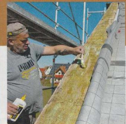
**8** Die Folie, die jetzt oberhalb der Zwischensparrendämmung liegt, ist später ein Teil der luftdichten Gebäudehülle. Als nächstes die Verklebung mit dem Giebelmauerwerk vorbereiten: Oberfläche abfegen und Grundierung auftragen.
