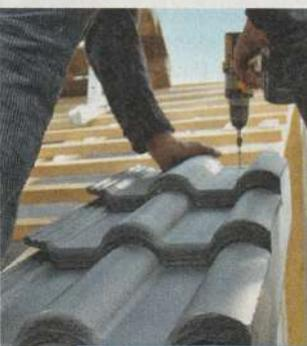
**31** Damit das Dach durch Windsogspitzen nicht abgedeckt werden kann, die Dachpfannen mit Sturmklammern fixieren. Die Ortsgangpfannen bekommen eine Verschraubung.
