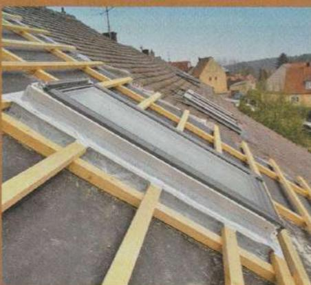
**29** ... danach von innen an die Klima-Membran hergestellt. Jeweils zugelassenes Spezialklebeband verwenden! Und so sitzt dann das Fenster im Lattenumfeld.
