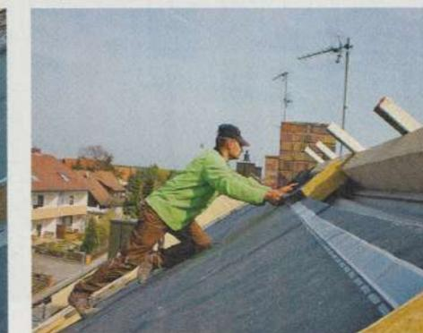
**22** ... Latten als Steighilfe arbeitet man bis zum First hoch und passt die Reststücke ein. Am besten von einer Dachseite her die Dämmelemente überstehen lassen.
