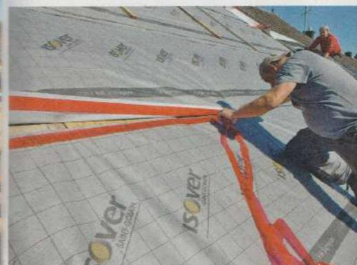
**12** Die beiden roten Liner abziehen und mit einer Hand nach vorne herausziehen. Mit der anderen Hand streicht man gleichzeitig die Folienstöße zusammen.
