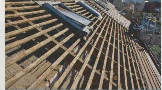
**2** Der sogenannte Rückbau der Dacheindeckung bereitet üblicherweise keine Probleme. Dachpfannen und Ziegel liegen lose auf der Lattung und können am First beginnend einfach abgenommen werden.
