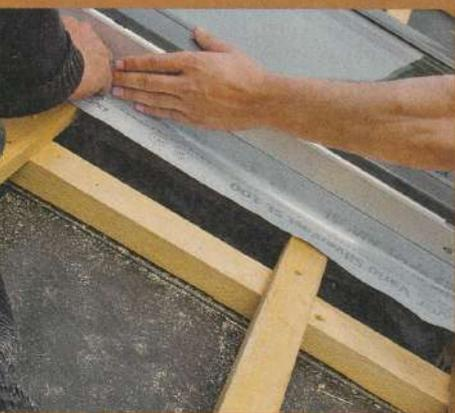
**28** Mit Dichtbändern wird das Dachflächenfenster wind- und wetterdicht an der Unterdeckbahn verklebt. Der luftdichte Anschluss wird ...
