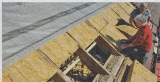
**7** Und so arbeitet man sich herunter bis zur Traufe – wobei immer auch gleich eine Dichtfolienbahn (Klima-Membran) quer über die Dämmlage gespannt wird.
