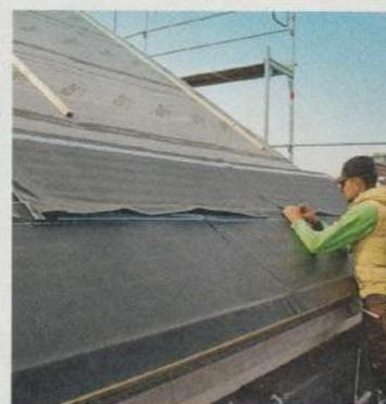
**20** Die Dämmplatten der nächsten Reihe deutlich seitenversetzt verlegen, um Kreuzfugen zu vermeiden.
