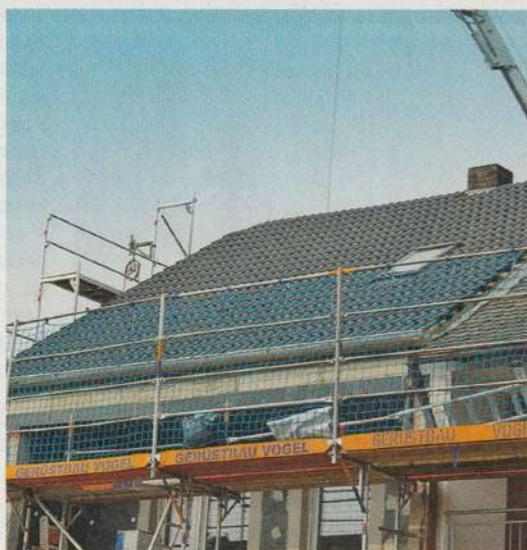
**32** Das Dach ist vollständig gedämmt und fertig eingedeckt. Die Dacheindeckung ist aus Beton und nennt sich Frankfurter Pfanne ([www.creation.de](http://www.creation.de)). Durch die zusätzliche Aufsparrendämmung ist der neue Dachaufbau nur 10 cm höher als das Nachbardach, das erst nach unserer Dämmmaßnahme ebenfalls saniert wurde.
