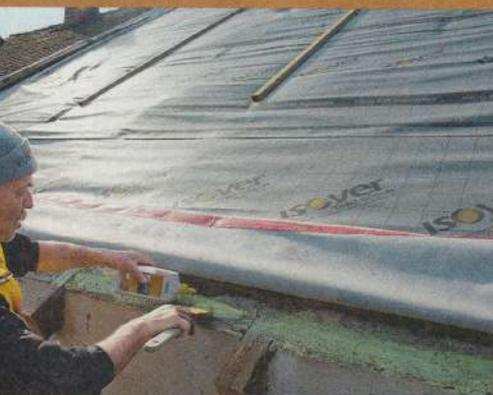
**14** Der traufseitige, luftdichte Anschluss der Folie an die Außenwand-Mauerkrone wird ebenfalls mittels Primer vorbereitet, den man mit Pinsel oder Rolle auftragen kann.
