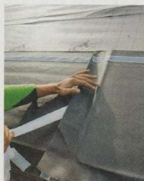
**19** Und so werden die Querstöße der Dämmplatten schnell und sicher überklebt und abgedichtet.
