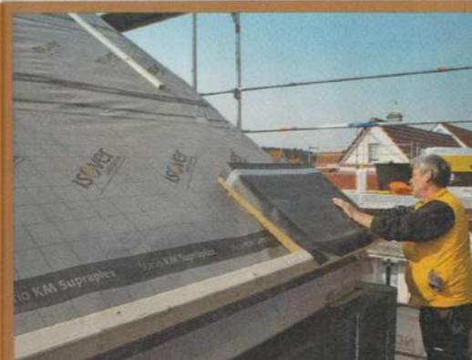
**17** ... Aufsparrendämmung anschrauben und die erste Dämmplatte direkt daran anlegen. Diese Dämmelemente sind aus hochverdichteter und formstabiler Steinwolle.
