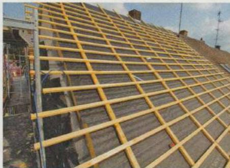
**24** Auf den Konterlattens werden die ziegeltragenden Dachlatten (Querschnitt 40 mal 60 Millimeter) mit Schrauben oder Nägeln sicher befestigt.
