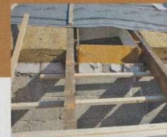
**6** ... so nicht durchs Betreten beim Arbeiten beschädigt. Mit einer provisorischen Sicherung längs der Sparren mit Hilfe von Latten bleibt die Folie auch bei Windböen sicher liegen.
