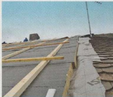
**23** Das Nachbardach wurde ein paar Tage später gedämmt. Ist das nicht der Fall, ist ein wetterdichter Übergang herzustellen.
