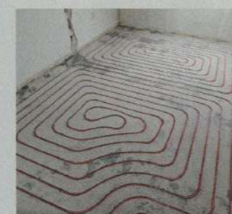
3 ... innerhalb des vorhandenen, alten Zementestrichs verlegt werden konnten. Das Fräsen selbst wurde nahezu staubfrei erledigt.
