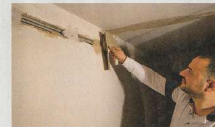
3 Vom Raumverteiler die Kabel zur nächstgelegenen Steckdose legen. Von dort alle weiteren Steckdosen versorgen. Stromkabel mit Innenputz fixieren, Kabelschlitze danach vollständig verfüllen.
