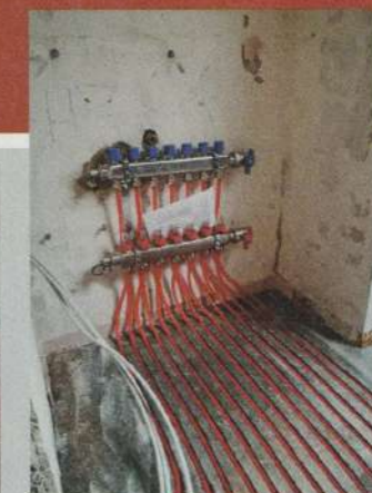
4 Am Etagenverteiler die Leitungen für die einzelnen Heizkreise anschließen: Unten den Vorlauf, oben den Rücklauf.
