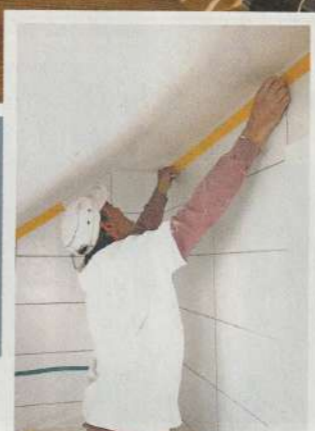
1 Sorgfältiges Abkleben von Türen, Fenstern, Fliesen und anderen angrenzenden Flächen für saubere Kanten.
