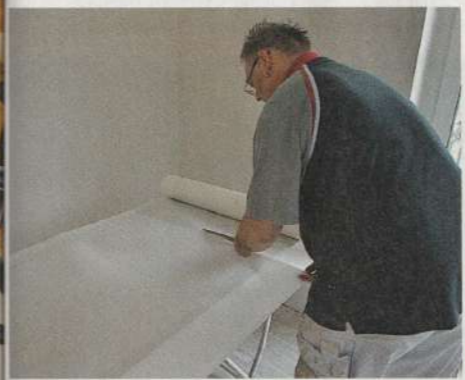
4 Sollen die Wände tapeziert werden? Dann dort eventuell auch eine Grundierung auftragen. Die Tapetenbahnen werden mit rund 10 Zentimeter Längenzugabe zugeschnitten.
