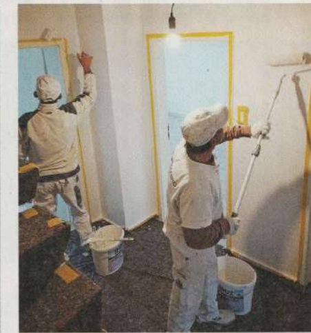
6 Glasfasertapeten bekommen zum Abschluss noch einen Deckanstrich. Die Räume und Flure erstrahlen jetzt in frischem Glanz.
