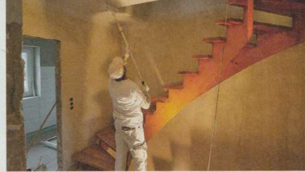
2 Wenn direkt auf der frisch gespachtelten oder verputzten Decke oder Wand der Anstrich aufgetragen wird, ist eine Grundierung zu empfehlen. Am besten lässt man sich hierzu im Fachhandel beraten. Die Farbe kräftig durchrühren und ...
