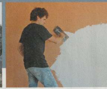
9 Der Lehmputzauftrag beginnt oben an der Decke. Er lässt sich sehr leicht verarbeiten, geht geschmeidig von der Kelle.
