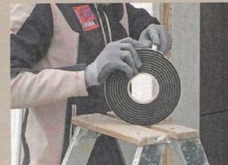
**6** Die Montage beginnt mit dem Aufkleben eines vorkomprimierten Dichtungsbands („Komriband“). Einmal rund um den Fensterrahmen abrollen. Es ist selbstklebend.
