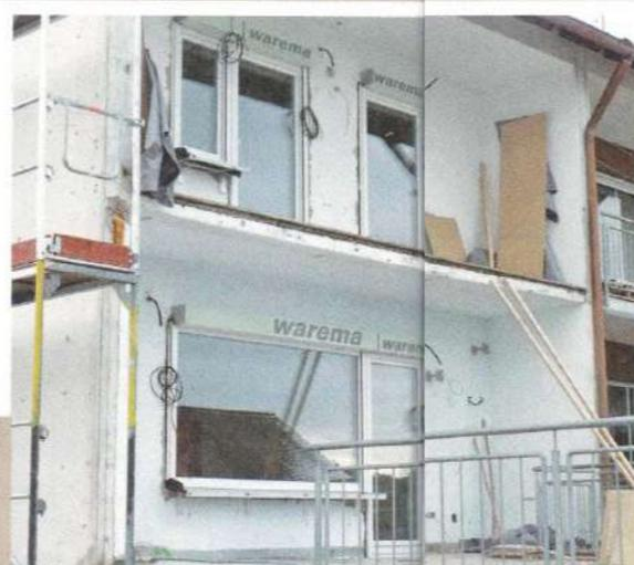
**27** Der letzte Schritt der Fenstermontage: gedämmten Rolladenkästen, die später in integriert sind. Die Stromkabel sorgen für
