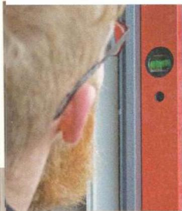
**11** ... Rahmen im Idealfall bündig mit der alten Fassade sitzen, damit die Dämmung übers Profil laufen kann.
