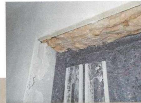
**4** Die alten Rollläden entfernen und den Hohlraum mit Mineralwolle füllen. Die neuen Rollladenkästen werden später in der Außendämmung integriert.
