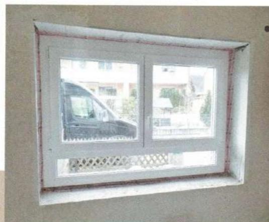
**23** Und so sieht ein innen rundum abgedichtetes Fenster aus. Auch nach unten hin zur Brüstungsmauer wird übrigens der Rahmen luftdicht abgeklebt.
