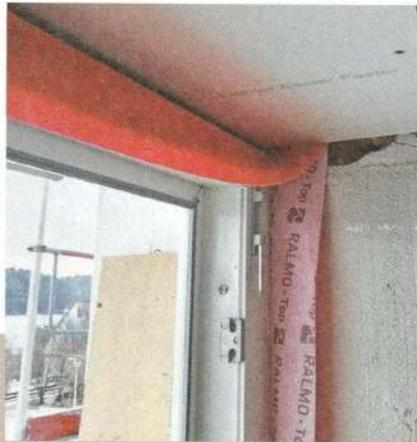
**21** Für den umlaufenden, luftdichten Anschluss der Rahmen wird nun das innenliegende Dichtband seitlich an der glatt verputzten Laibung angeklebt.
