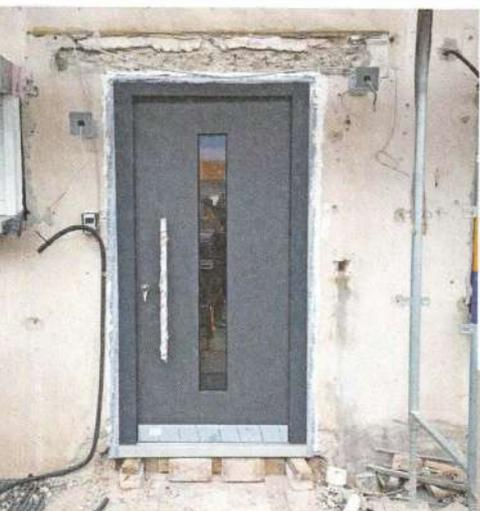
**25** Außen werden in der Wetterschutzebene alle Fenster- und Türanschlussfugen diffusionsoffen, schlagregensicher und winddicht ausgeführt.
