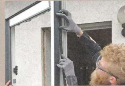
**7** Das Band in Rahmenbreite oder in zwei schmalen Streifen jeweils an den Rändern ankleben. Es quillt nach der Montage langsam auf und dichtet den Hohlraum zwischen Rahmen und Mauerwerk ab.
