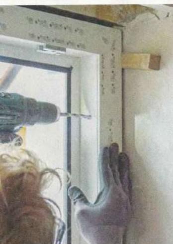
**13** Nun Löcher etwa 10 bis 15 cm vom inneren Rahmeneck durch den seitlichen Fensterfalz bohren.
