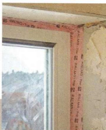
**22** Ebenso oben im Sturzbereich (hier an der Abdeckung des ehemaligen Rollladenkastens). Selbstklebebänder sparen Zeit.
