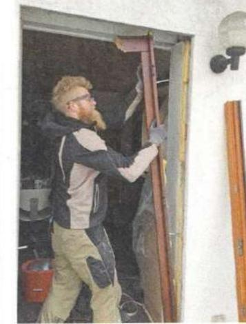
**2** ... innen zum Innenputz mit einer Trennscheibe aufschneiden (Staubmaske tragen) und dann den alten Rahmen herausbrechen.
