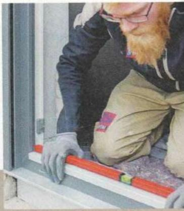
**10** Die Rahmen nun mit der Wasserwaage ausrichten. Wenn später die Fassade gedämmt wird, sollten die ...
