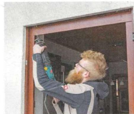
**1** Rückbau der alten Fenster: Sobald die alten Fensterflügel ausgehängt sind, die Rahmen in der Nähe der Ecken mit einer Säbelsäge durchtrennen. Den Übergang ...
