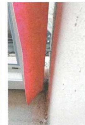
**20** Die Fenster sind fixiert, die Arbeitsschritte für Dämmung und Dichtung beginnen. Das Komprimband ist noch nicht ausgedehnt.
