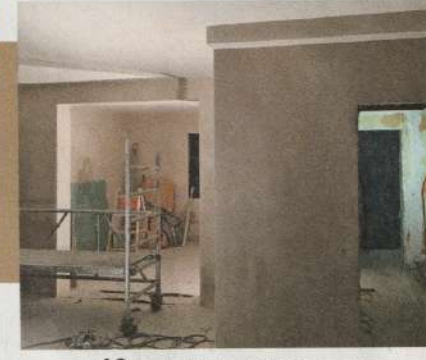
9 ... kräftig abgerieben werden kann. So gleicht man letzte Unebenheiten aus. Zum Schluss mit dem Flächenspachtel („Schmetterling“) glattziehen.
