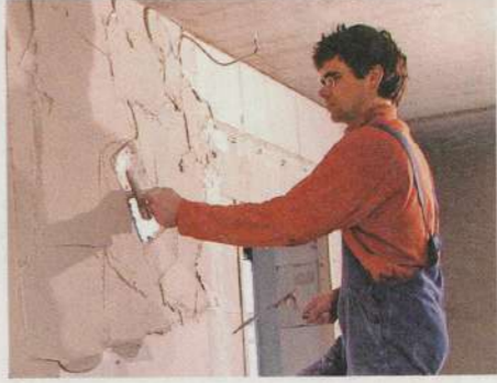
6 Beim Verputzen arbeitet man von der Decke bis zum Fußboden, um bearbeitete Bereiche nicht zu verschmutzen. Die frische Putzmasse mit der Traufel in ...
