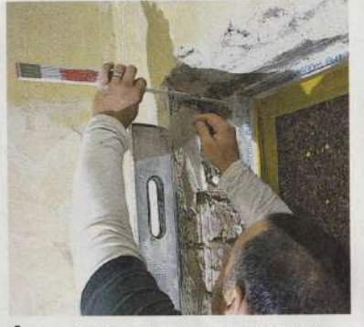
4 Wenn ein frischer Innenputz gewünscht ist, setzt man zunächst an den Mauerwerksecken Putzprofile für saubere und stabile Kanten.
