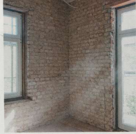
2 Vorbereitung: Den alten Putz vollständig entfernen, wenn er zu sehr bröckelt. Ansonsten Oberflächen abbürsten, lose Teile entfernen, stark saugende Untergründe grundieren.
