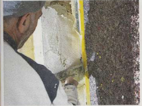
5 Die Profile fixiert man mit einzelnen Mörtelbatzen (mit der Wasserwaage ausrichten). An Fenstern und Türen die Laibungen vollständig verfüllen.
