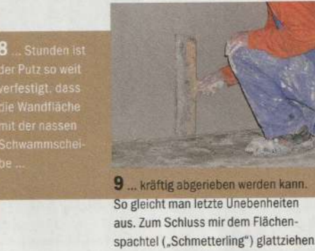
8 ... Stunden ist der Putz so weit verfestigt, dass die Wandfläche mit der nassen Schwammscheibe ...
