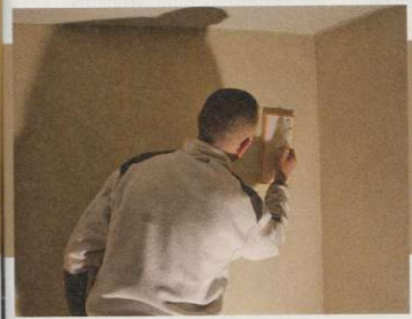
5 Die Profile fixiert man mit einzelnen Mörtelbatzen (mit der Wasserwaage ausrichten). An Fenstern und Türen die Laibungen vollständig verfüllen.
