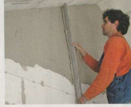
7 ... einer Handbewegung von unten nach oben aufziehen, gleichmäßig verteilen und mit der Richtlatte vorglätten. Nach ein bis zwei ...
