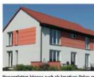
Boosterplatten können auch als knothenes Dekor an der Fassade angeordnet und farblich hervorgehoben werden.
