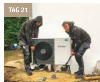
TAG 21 Wärmespender Am vorletzten Tag wird schließlich auch die Außen-einheit der Wärmepumpe installiert.
