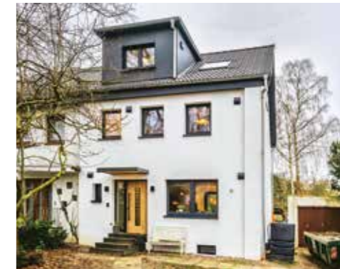
Vorher – Nachher Zwischen diesen Bildern liegen gerade mal 22 Arbeitstage. Die waren allerdings prall gefüllt: Bis zu 60 Handwerker waren an diesem Sanierungssprint beteiligt.
