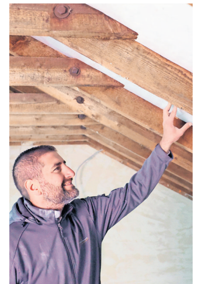
Maximilian Chamaoun ist der Sanierungssprintcoach auf der Löchgauer Baustelle. Er erstellt Bauzeitenpläne und koordiniert alles.
